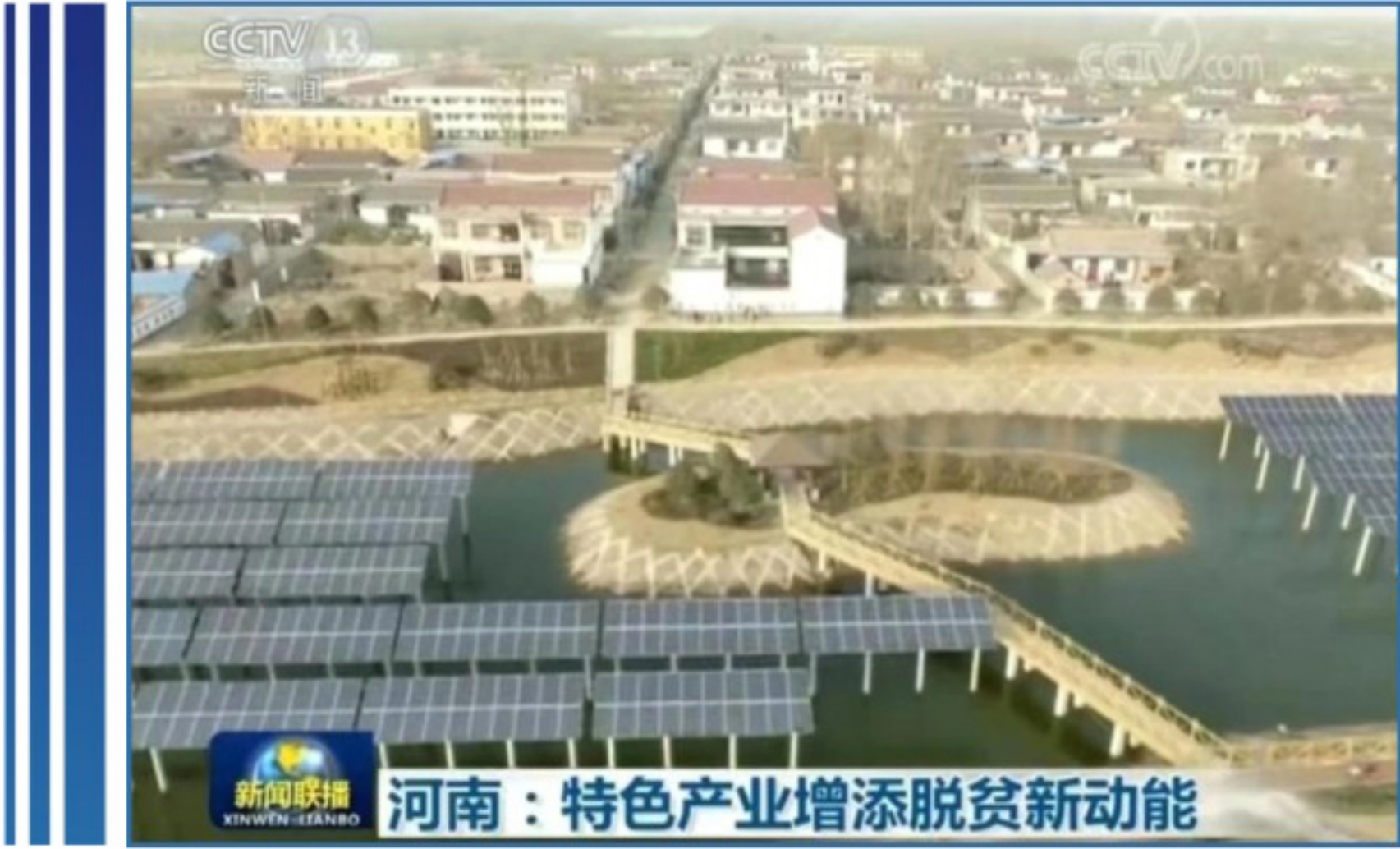
央视新闻报道 河南周口“渔光互补” 光伏扶贫项目
